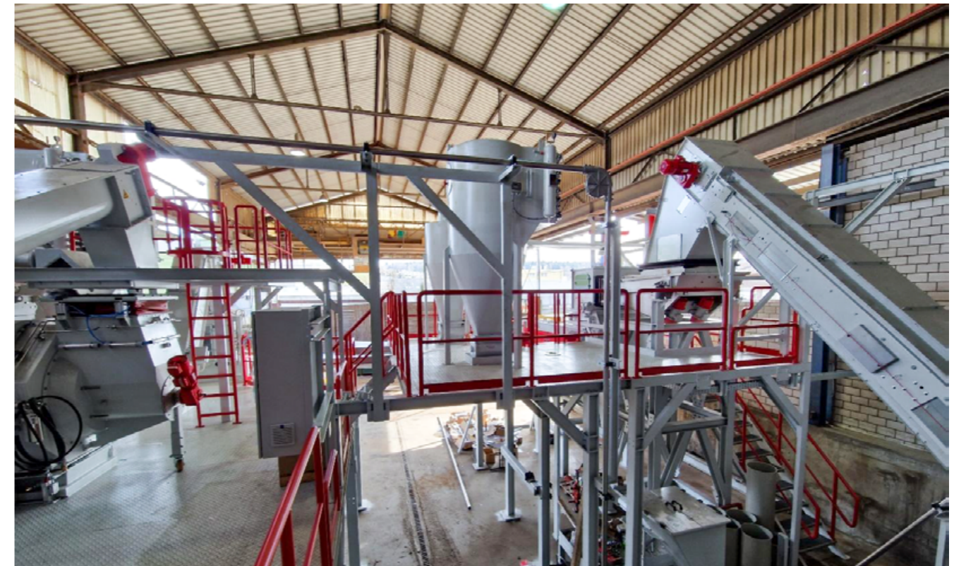
Installation de recyclage pour appareils frigorifiques URT de l'entreprise E. Flückiger AG en cours de construction.
