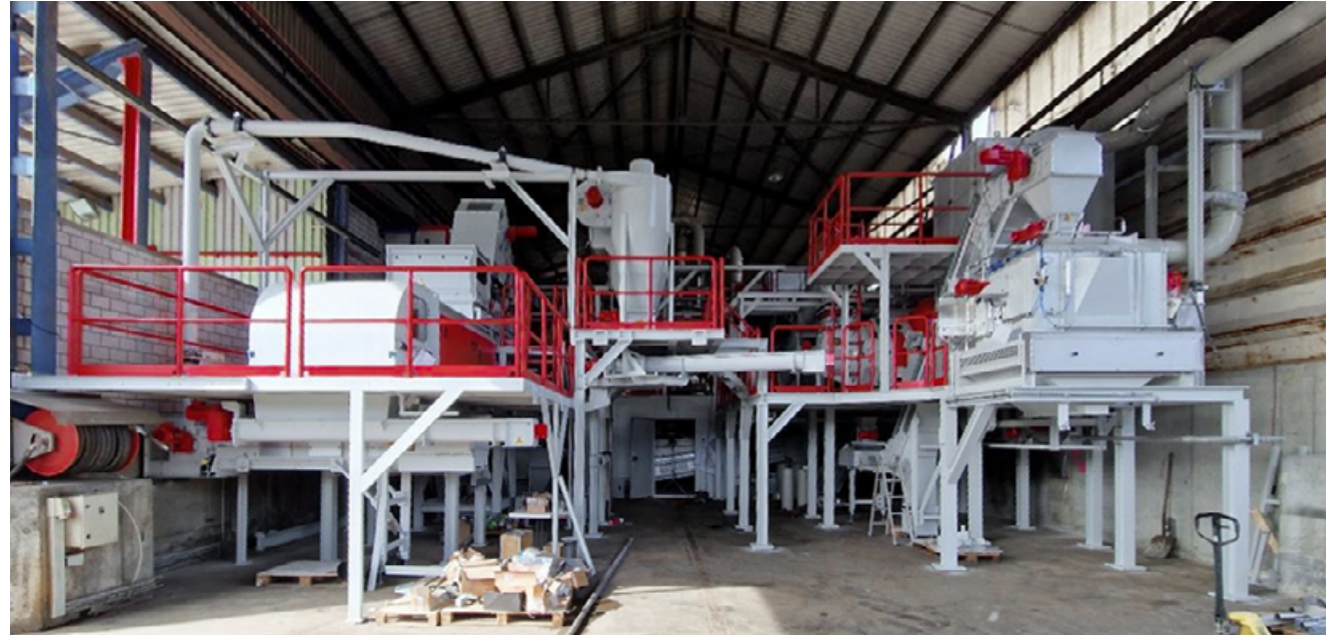
Installation de recyclage pour appareils frigorifiques URT de l'entreprise E. Flückiger AG en cours de construction. À gauche: séparateur à courants de Foucault, à droite: unité de refroidissement des granulés.
